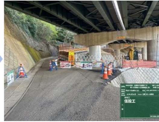
【仮設工】 R5. 2. 20～ 仮囲設置 仮設ガードレール設置
