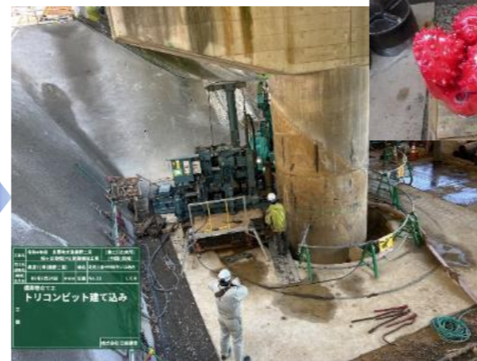
【先行掘削工】 R5. 4. 12～7. 18 15cm以上の石等があると鋼板圧入が できない為、ボーリングマシンにより 礫層及点石の掘削を行い、セメント・ ベントナイトの置換を行った。
