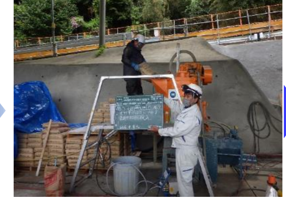
【先行掘削工】 CB(セメント・ベントナイト)の 配合注入 配合は既設地盤のN値30を基準 に計画しました。
