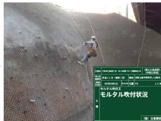
【モルタル吹付工】R5. 4. 3～4. 6 モルタル吹付工 勾配1:0.6 t=10cm
