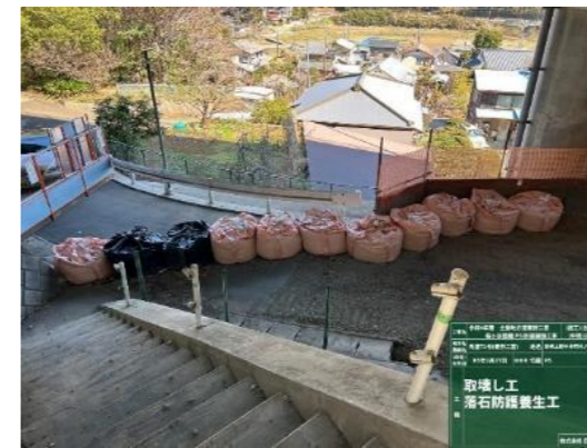
【仮設工】 構造物撤去時に落石防止の為に 大型土嚢の設置し養生を行った。
