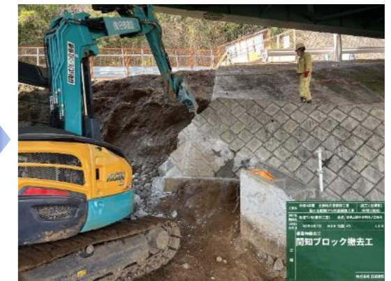
【施工ヤード確保施工】R5. 2. 20～3. 23 施工ヤード確保の為に防護柵・ 構造物の撤去及び土工事を行った。
