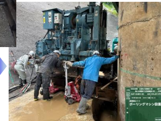
【先行掘削工】 橋脚回りに34箇所トリコンビットにて 掘削を行います。マシン移動の際、 クレーンが使用できない為、ハンドパ レットを使用し、人力で移動設置しま した。
