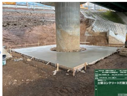
【施工ヤード確保施工】R5. 3. 27 施工ヤードの土間コンクリート
