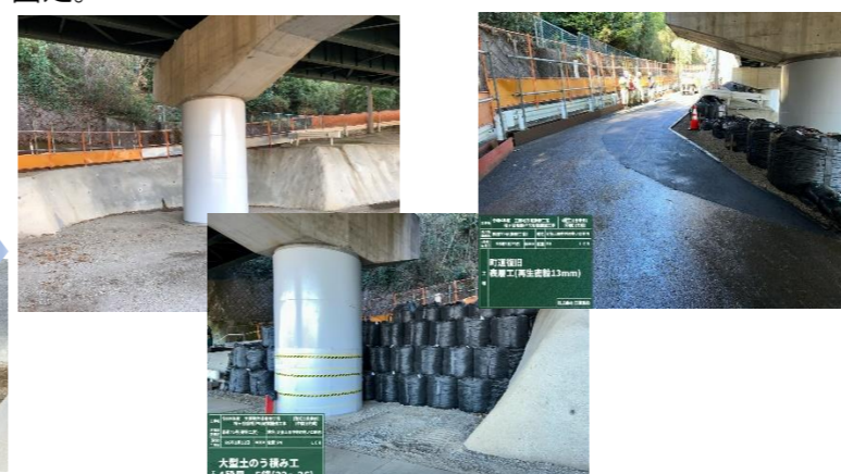
【補強鋼板組立】R5. 10. 18~10. 20 足場を一部解体し、鋼板の組立。アンカーボルトにてクリアランス3cmを確認しながら約240箇所ボルト固定。
