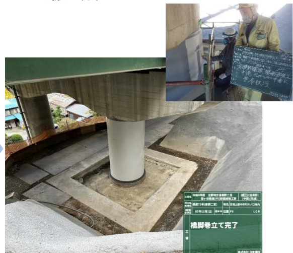
【現場塗装・完了】R5. 11. 13~12. 1
