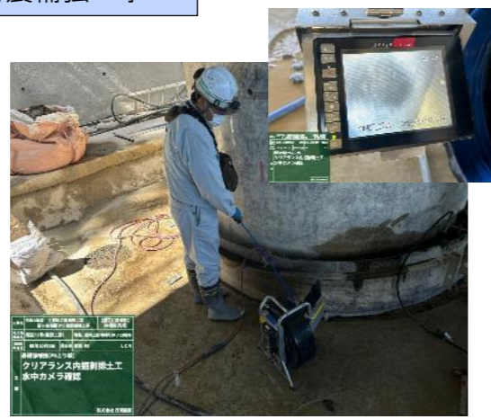
【クリアランス内排土工】R5. 10. 10 水中カメラを使用して、排土状況の確認を行います。
