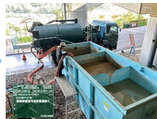
【汚泥処分】R5. 10. 18 濁水処理装置で仕分けた汚泥を吸泥車にて運搬処分。
