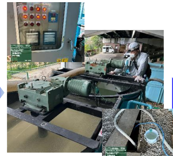
【濁水処理放流】R5. 10. 4~10. 13 濁水を濁度50mg以下/L・pH6. 5~8. 5を確認してから側溝に放流。
