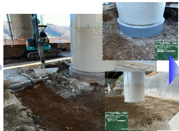
【土間コンクリート撤去・埋戻】R6. 1. 9~10 土間コンクリートの撤去し、補強鋼板に錆止め塗装を行ったのちに、発生土にて埋戻しを行った。
