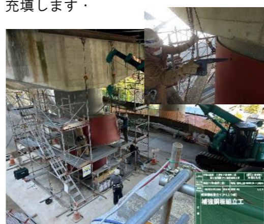
【補強鋼板組立】R5. 10. 18~10. 20 足場を一部解体し、鋼板の組立。アンカーボルトにてクリアランス3cmを確認しながら約240箇所ボルト固定。
