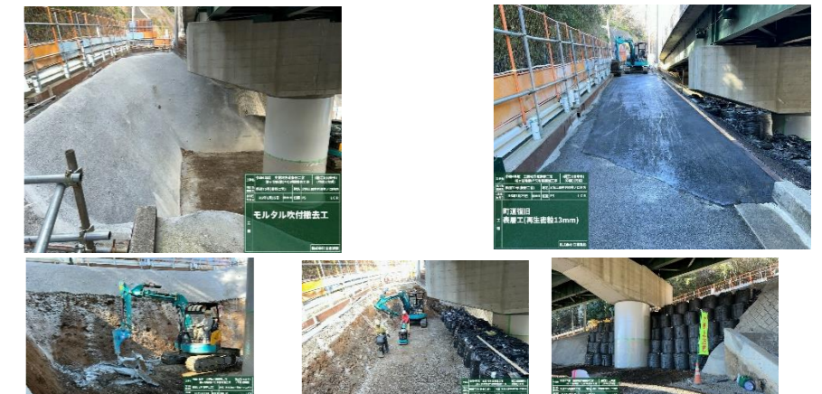
【町道復旧工】P4 R6. 1. 10~1/. 31 町道(側道)の一般車通行可能にするために、モルタル吹付撤去後大型土のうを積み砕石にて埋戻しを行い、舗装をした。
