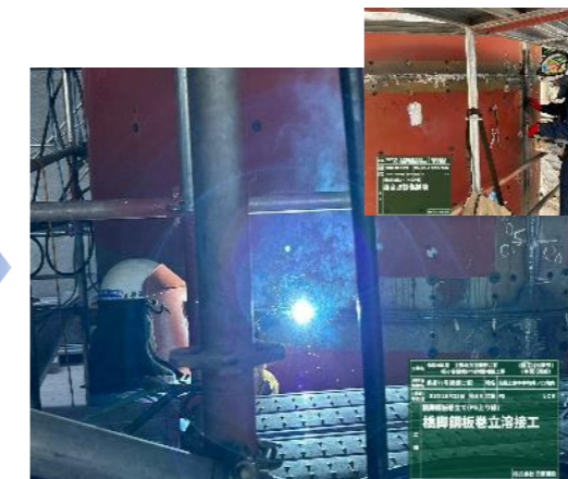
【補強鋼板溶接】R5. 10. 23~10. 25 補強鋼板の接続部を半自動溶接し、超音波探傷試験を行った。
